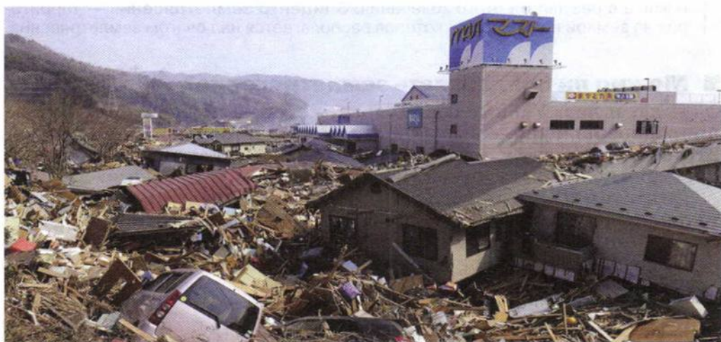
Рис. 118. Последствия сильного землетрясения
